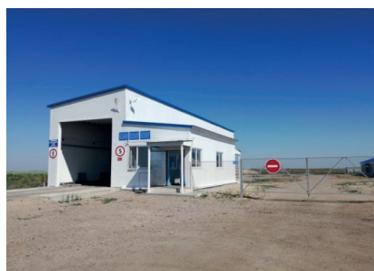
Рисунок 2 – Дезбарьер под навесом, для дезинфекции автотранспорта свинокомплекса
